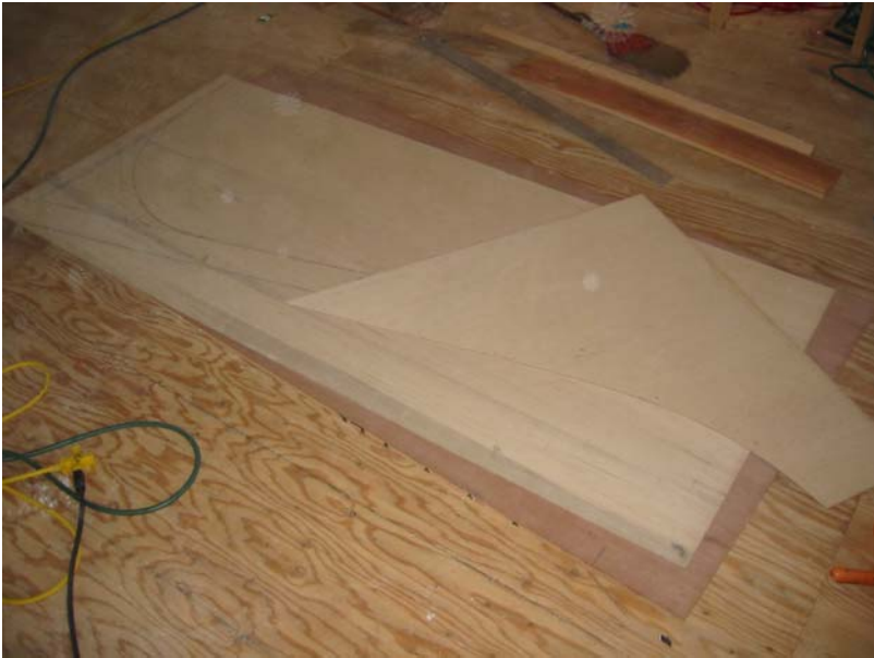
5ミリFGボードを水で濡らして曲げて乾燥させ、これを2枚貼りとしている。
