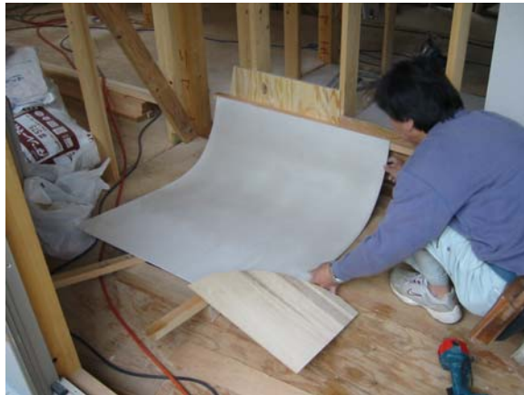
5ミリFGボードを水で濡らして曲げて乾燥させ、これを2枚貼りとしている。
