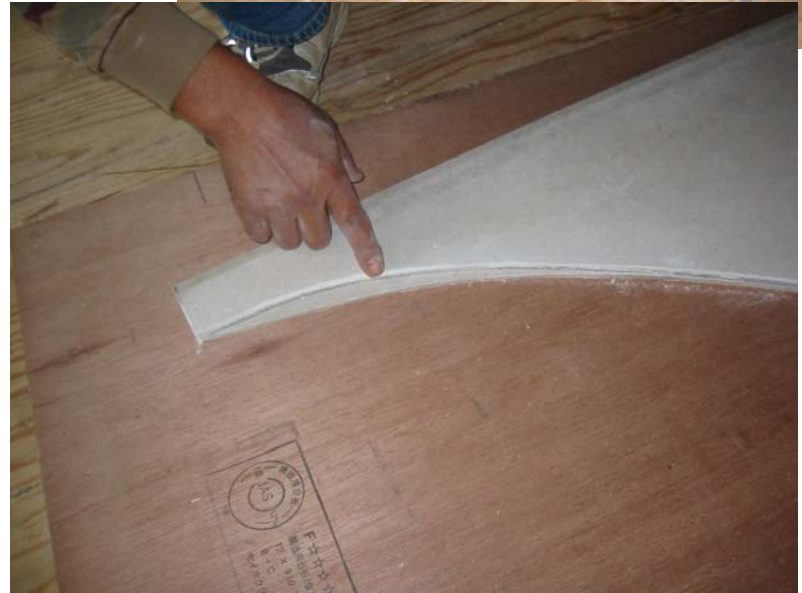
外側のラインが原寸図の理論値で、指先のラインが施工誤差を生じたライン
